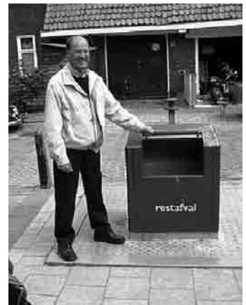
▲オランダにある地下ゴミ箱
