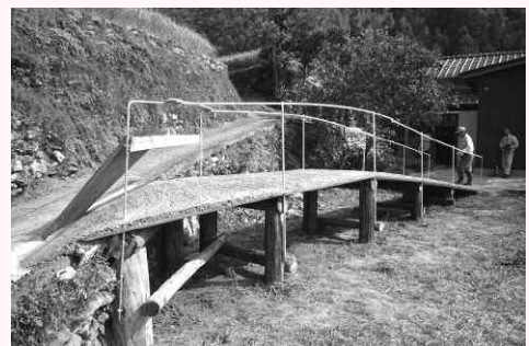
▲ボランティアで作った車いす用スロープ
