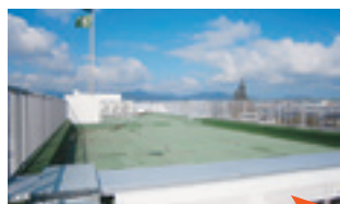
松茂中学校 屋上手すり
