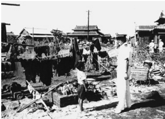
被災した家屋(長原地区)
