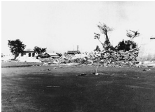
今切川左岸長原地区の破堤
