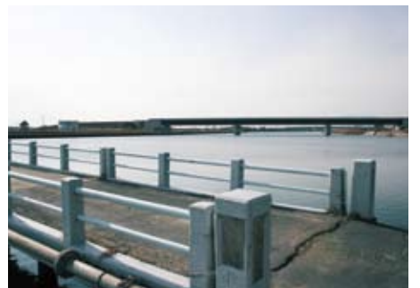
(写真3) 手前・町道「長岸橋」、奥・四国横断道「仮称長岸橋」
