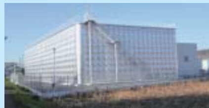
昨年9月に完成した浄水場
