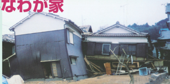
阪神・淡路大震災で 倒壊した木造住宅
