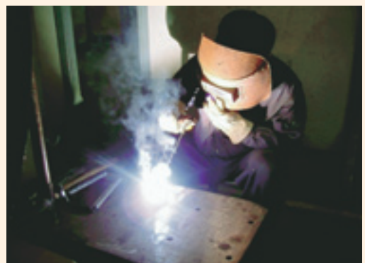
被覆アーク溶接
