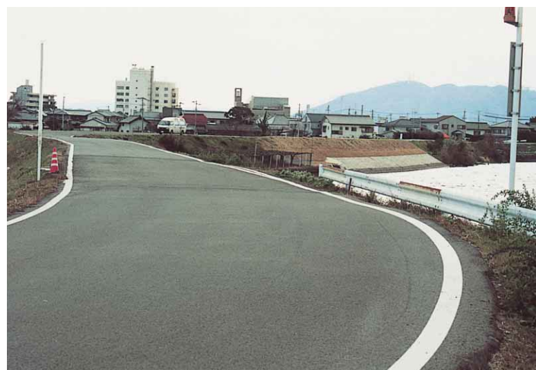
旧吉野川堤防にガードレールの設置を
