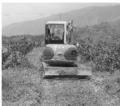
園内道の新設状況
