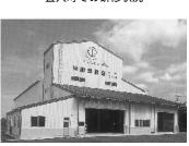
直入町現地研修カントリーエレベーター (荷受・乾燥・貯蔵の攪撹拌装置付50 t 角型 ン33基により高品質累積混合撹拌ができる)
