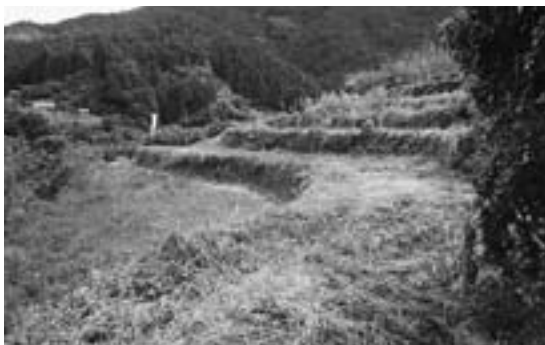
▲復旧前の農地
