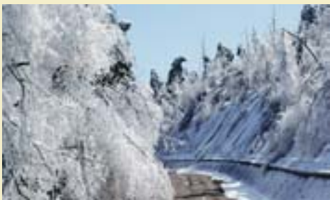
▲雨氷被害を受けた林道の樹木
