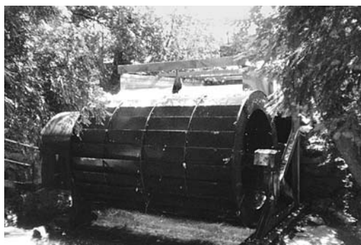
小さな水路での水力発電施設
