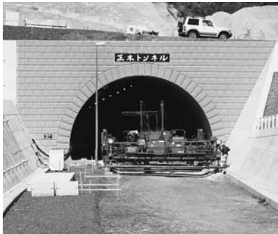
開通に向けて工事の進む正木トンネル
