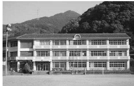
地球温暖化防止に太陽光発電を設置している上勝小学校
