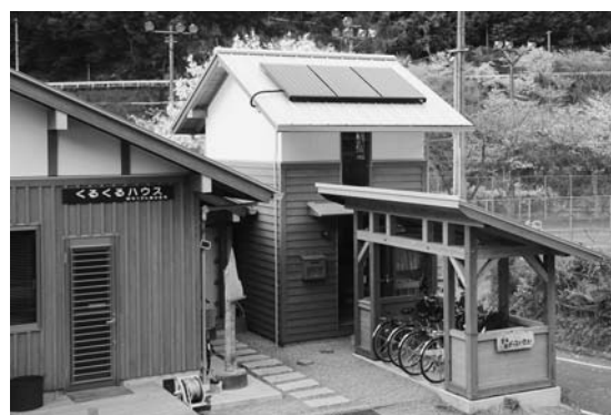
くるくるハウスの太陽光充電駐輪場
