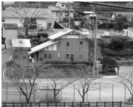
（株）もくさんのモデル住宅（平間地区）建設中
