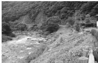
▲ 景観整備が実施された馬瀬川沿い
