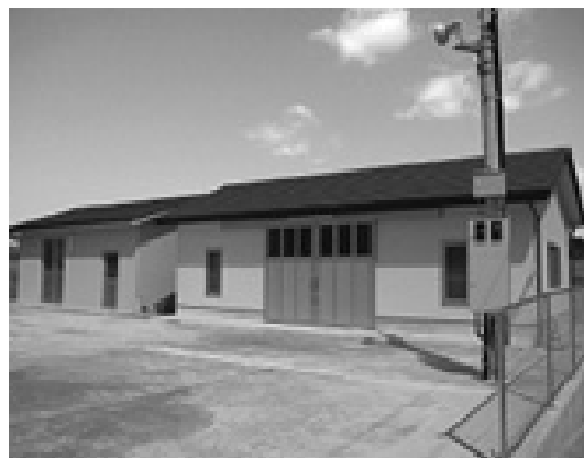
新水源地（高園字大山白55番地2）
