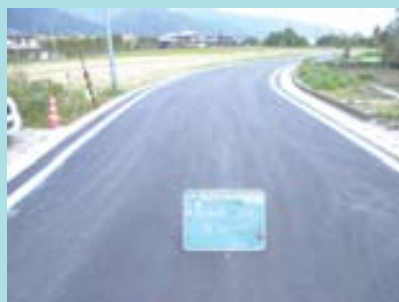
施工後(町道宮の北線)
