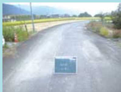
施工前(町道宮の北線)
