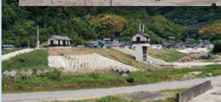
深瀬地区工事状況
