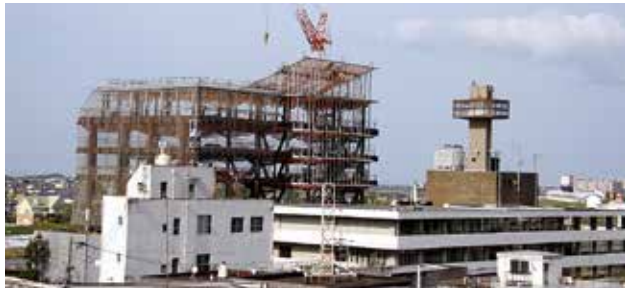
現在、高層部（7階建て）を建設中
