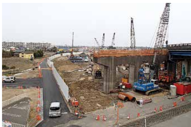
一般国道55号阿南道路工事状況（那賀川町中島付近）※
