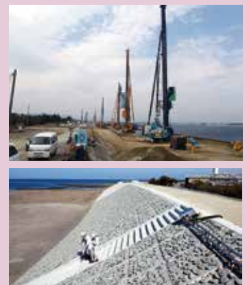
那賀川河口部工事状況 (上段：液状化対策、下段：堤防高上げ)
