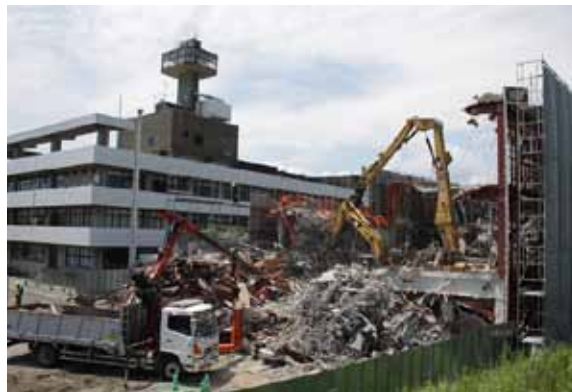
分庁舎を解体する様子。(8月18日現在)
