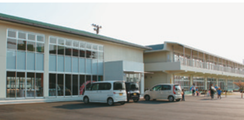
藍住北幼稚園遊戯室の改築・園舎の改修
