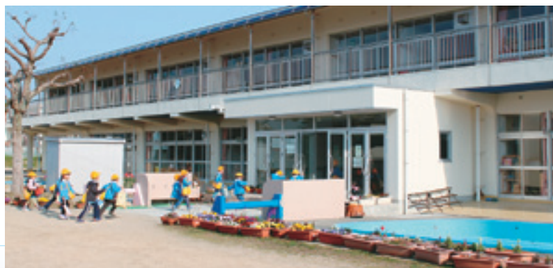
藍住南幼稚園遊戯室の補強・園舎の改修
