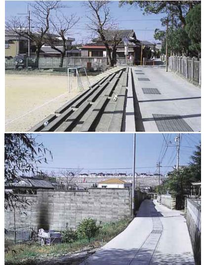
図2 板野東小学校グラウンド北側を通る道路と低断層崖(図1の●印)。道路を境に左側(南側)が右側(北側)に対して1.5～2m落下している。
